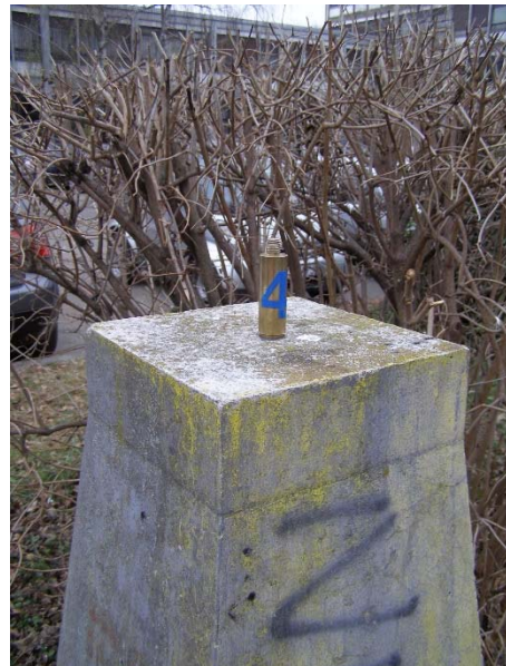
Slika 10. Stabilizacija točke GTSK.
