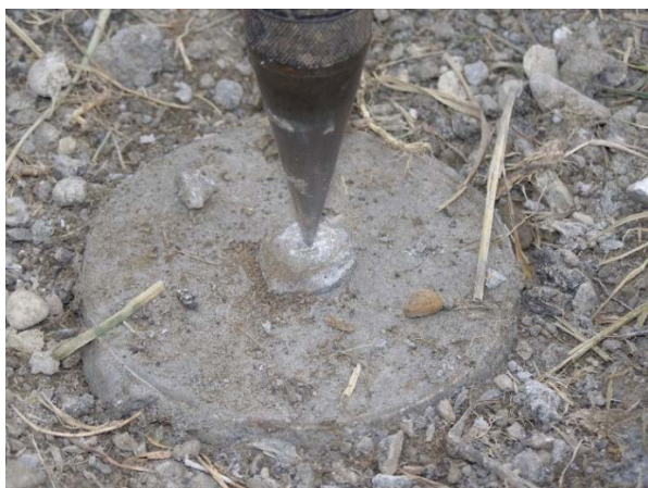
Slika 1. Stabilizacija GNSS točke na zemljanoj površini: metalna šipka u plastičnoj cijevi zalivenoj betonom.
